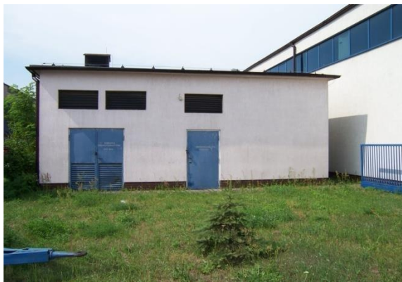
Рис.2 Здание трансформаторной станции
