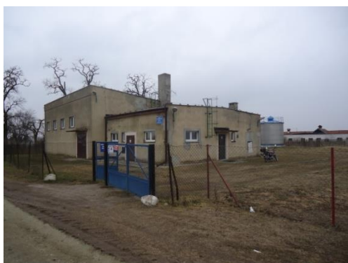
Рис.8 Установка очистки воды (SUW)
